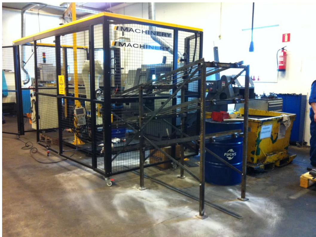
Kuva 27. Uusi aihiomakasiini koottuna ja asennettuna paikalleen.
