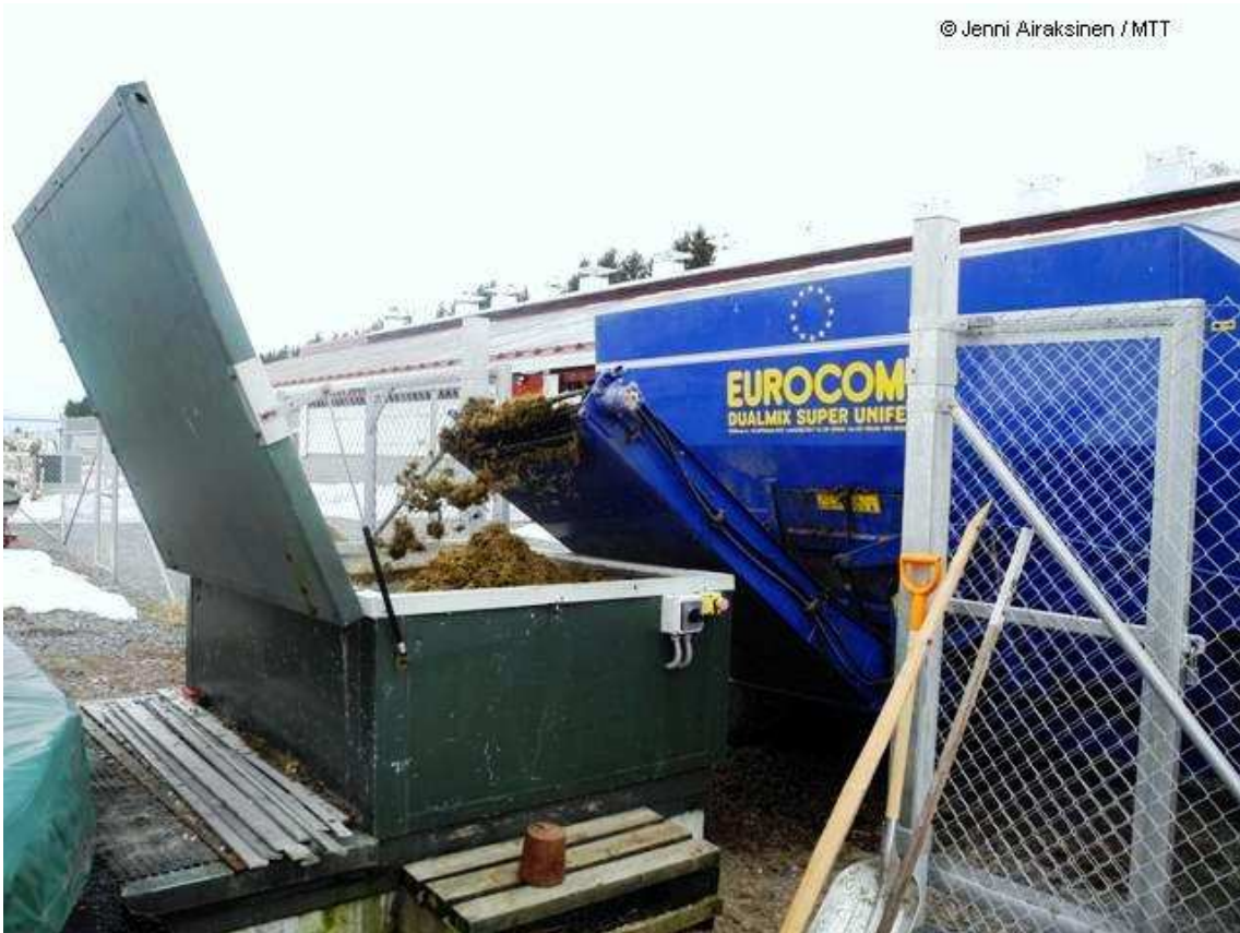
KUVIO 4. Ruokohelpi syötettiin apevaunun avulla syöttöruuville. Syöttöruuvien avulla kasvimassa saadaan syötettyä reaktorin lietepinnan alapuolelle.
