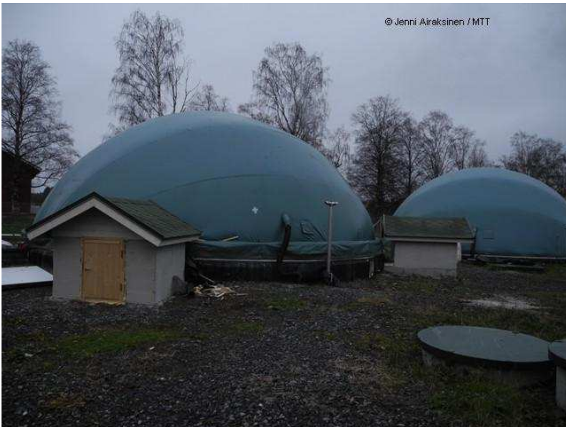
KUVIO 8. MTT Maaningan biokaasulaitoksen reaktori (edessä) sekä jälkikaasuallas. Aamutarkastuksella tarkistettiin kummankin sääsuojakuvun ikkunasta kaasuväkästä kokoa.
