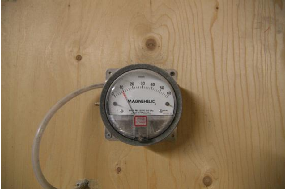
KUVA 7. Työmaan alipaineen tarkkailemiseen käytettävä mittari
