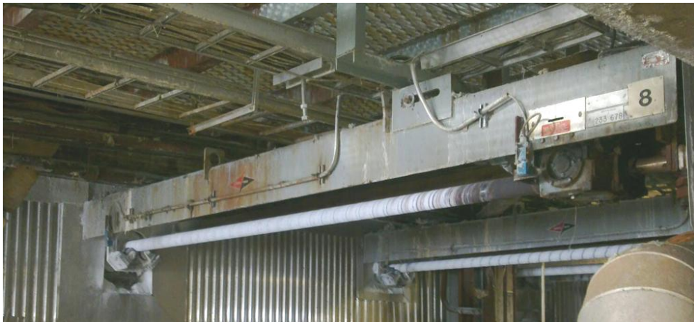
Kuva 6. Soodakattilan höyrynuohoin
