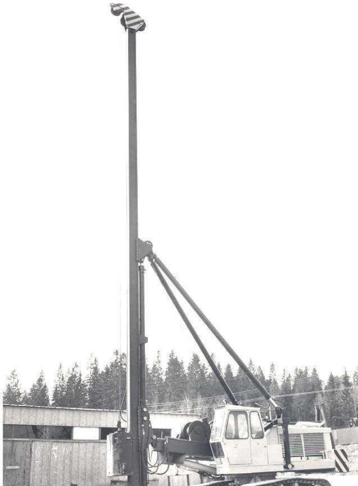
KUVA 1. Ensimmäinen Junttanin valmistama hydraulinen lyöntipaalutuskone. (Junttanin kuva-arkisto)
