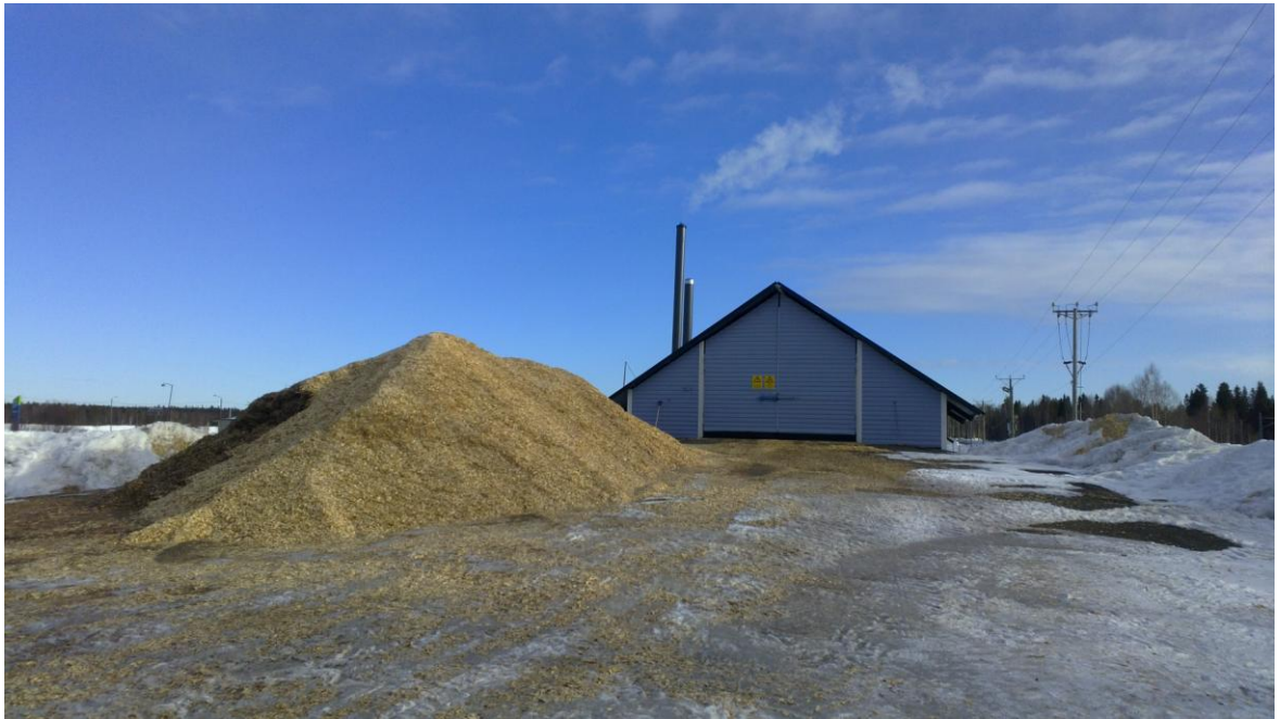
Kuva 2, Biolämpövoimalaitos Tervolassa, polttoaineensyöttöpuoli.
