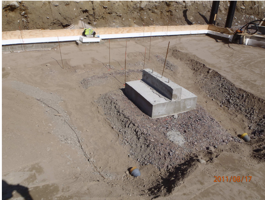
Kuva 2. Alapohjan viemäriarinat valmiina lvi-urakoitsijaa varten. (Kuva: Rafael Lindberg)
