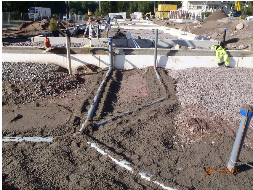
Kuva 3. Alapohjan viemäreiden alkutäyttö käynnissä. Taustalla tasolaseri kaatojen tarkistamista varten. (Kuva: Rafael Lindberg)
