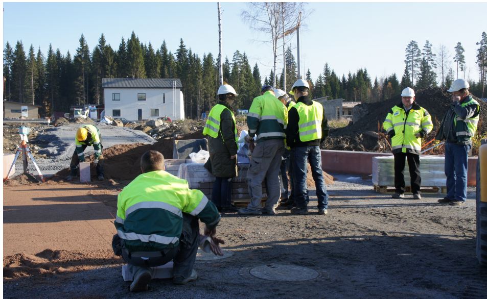
Kuva 2. Kuva työmaakatselmuksesta Kirjailijanpuistosta 25.10.2011. Paikalla oli tilaajan ja urakoitsijan edustajia sekä valvoja. Kuvassa on meneillään kiveyksen malliladonta, jonka tilaaja ja valvoja hyväksyvät. Kuva: Heidi Vävilä.
