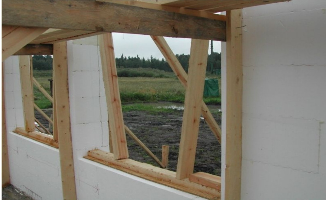
Kuva 9. Päätyharkkojen käyttö aukkojen kohdalla (Piikkiön Sementtivalimo M. Alander Oy 2012e).
