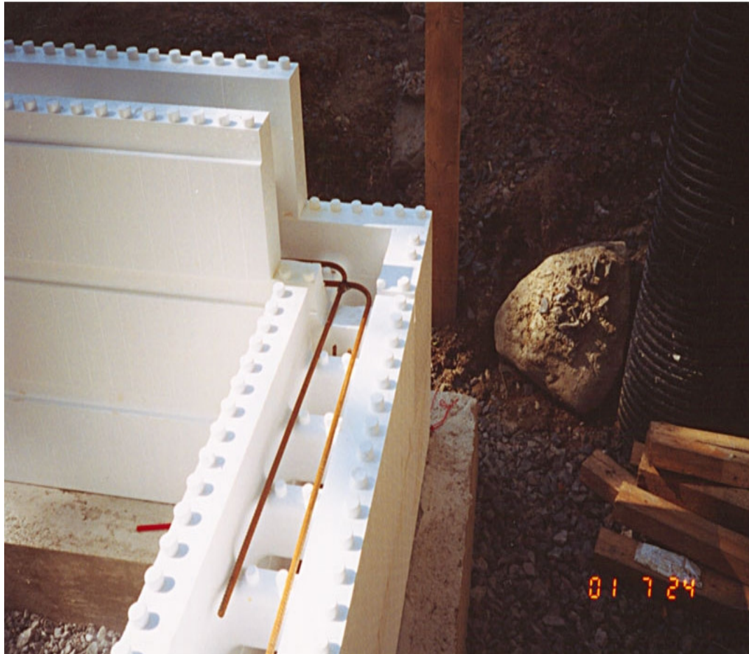
Kuva 8. Harkon nappulapontit ja terästystä (Piikkiön Sementtivalimo M. Alander Oy 2012b).
