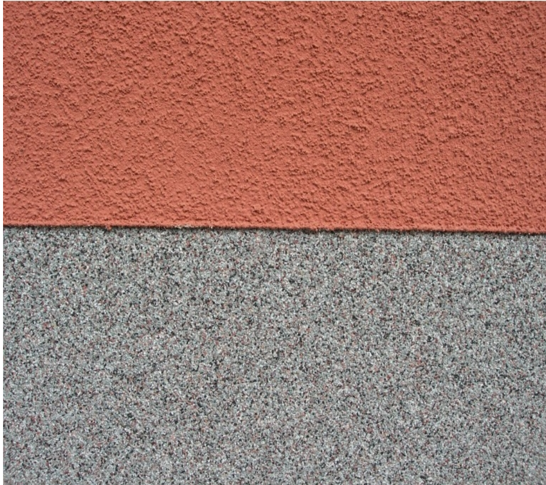
Kuva 15. Rappauksen rajaus muovilistalla (Piikkiön Sementtivalimo M. Alander Oy 2012a).
