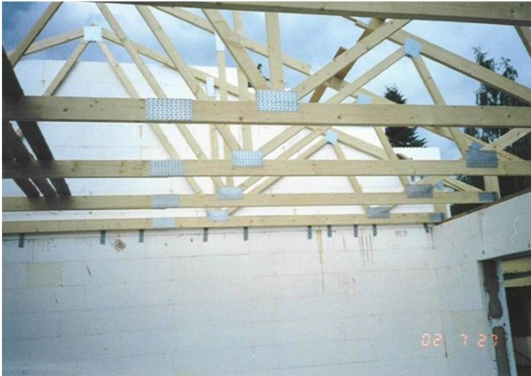
Kuva 11. Päätykolmio valuharkkoista (Piikkiön Sementtivalimo M. Alander Oy 2012d).
