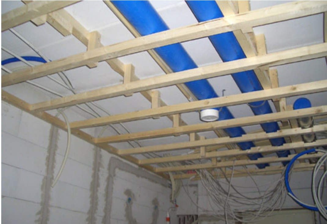
Kuva 14. Mallikuva alaslasketusta katosta tekniikoineen (Rakentaja 2012).
