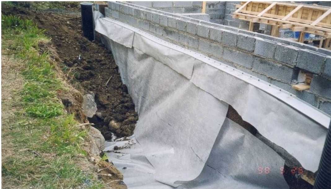
Kuva 6. Suojalista ja suodatinkankaan asennus (Piikkiön Sementtivalimo M. Alander Oy 2012k).
