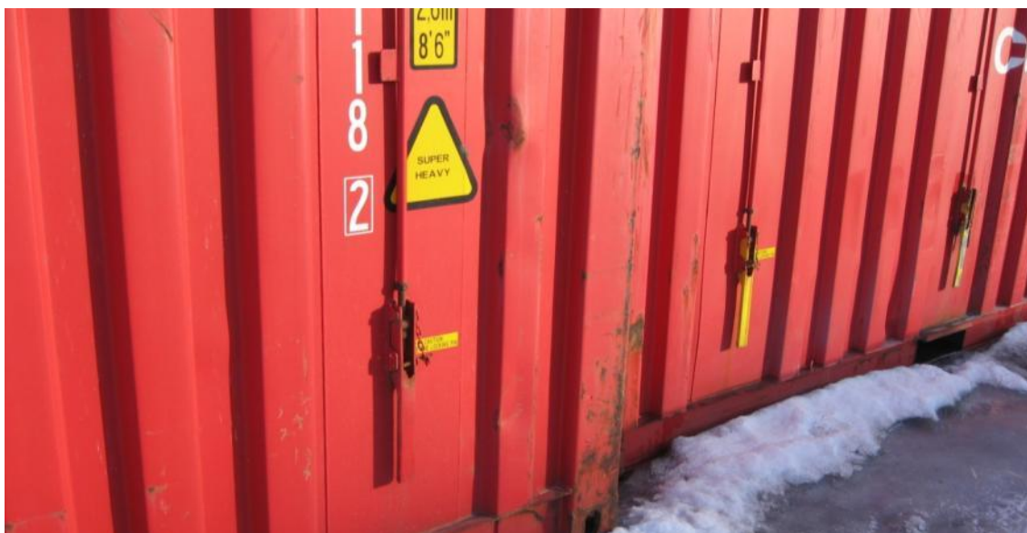
Kuva 31. Maalattu ja maalaamaton kattosalpa (Suopajärvi 2012.)
