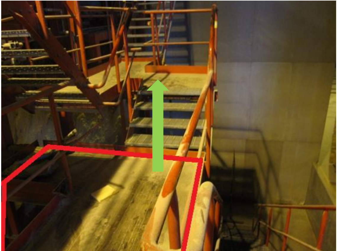
Kuva 4.9 Syöttökuljettimen oikeanpuoleiset kulkutasot
