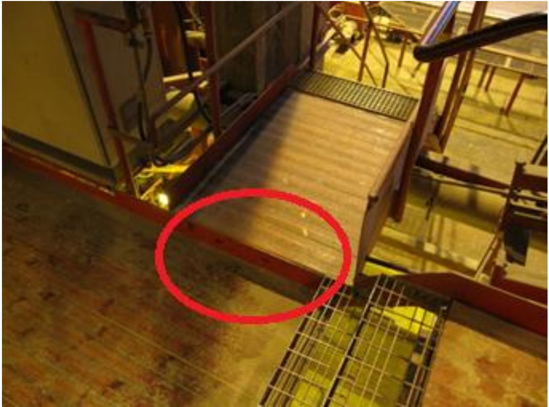
Kuva 4.5 Paketointiin johtavat portaat
