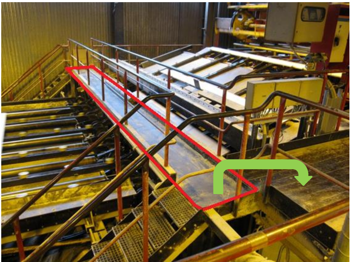
Kuva 4.30 Kuljettimen ylittävä silta
