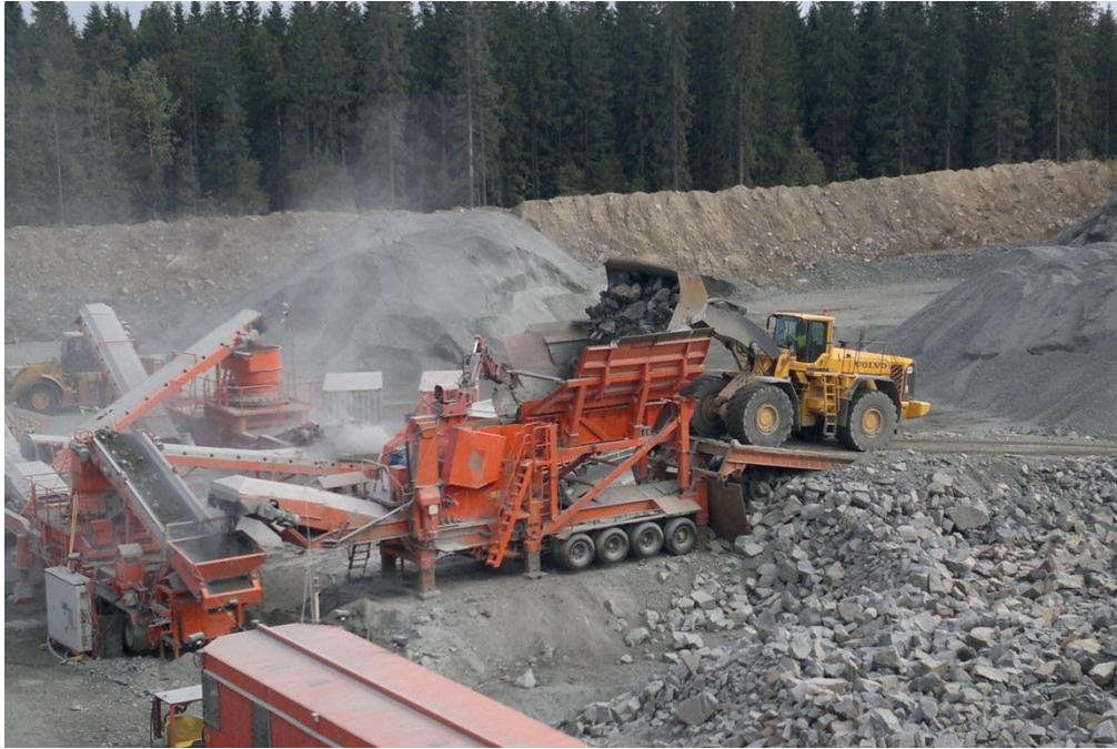
Kuvio 5. Pyöräkuormaaja syöttämässä pyöräalustaista murskaa
