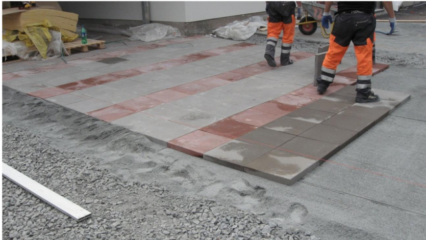
KUVIO 6. Betonilaatoituksen viimeistelytyöt käynnissä
