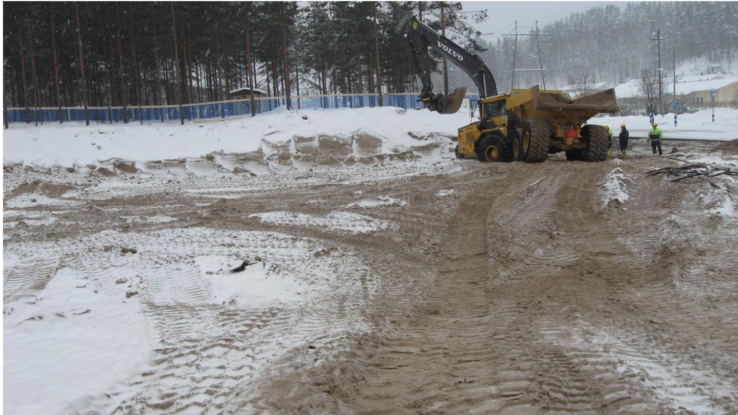
KUVIO 5. Kalusto on siirtynyt työmaalle ja työt käynnistetty
