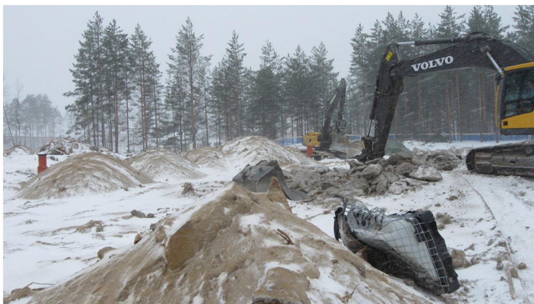
KUVIO 2. Maarakennustyömaa talviolosuhteissa
