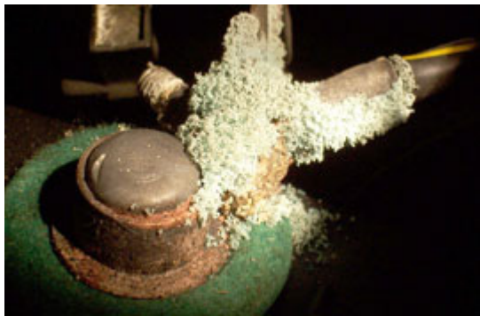
Kuva 1. Hapettunut akunkenkä. Akun napojen ja akkukenkien puhtaus on koko veneen sähköjärjestelmän kannalta elintärkeää. Akun napojen puhtaus tulee tarkistaa vuosittain. (Honda hot list –blogi 16.4.2012.)
