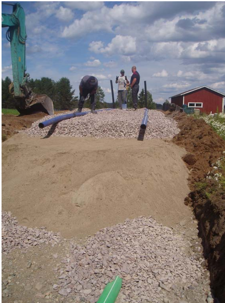
KUVIO 5. Maasuodattamon rakentaminen, Kuhmo. Kuva Eero Kananen 2006.
