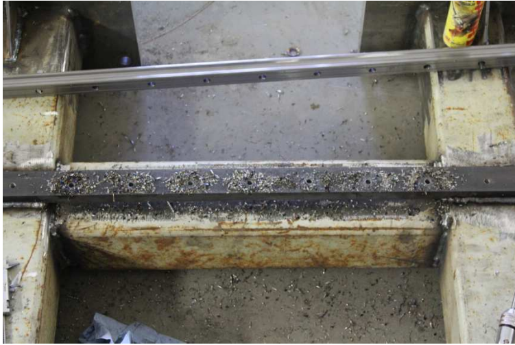
Kuva 4. Pylvään johdepintojen poraus.
