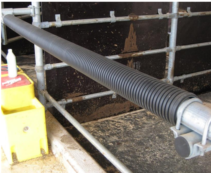
Kuvio 17. Niskaputkeen asennettu salaojaputki.
