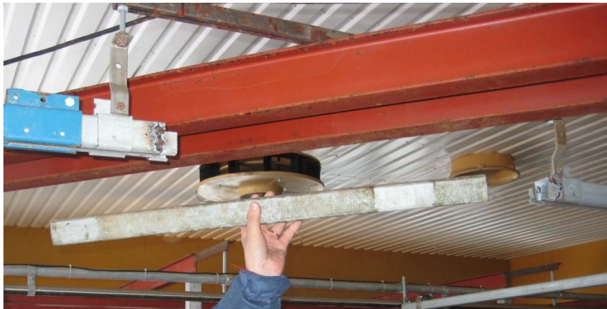
Kuvio 19. Lypsykiskoon asennettu portti, irrotettava malli.
