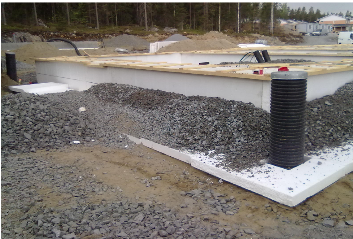
KUVA 4. Routasuojauksen asentaminen muotin ulkopuolelle
