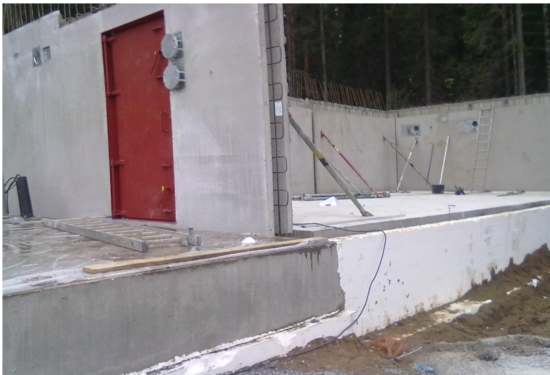
KUVA 7. Soklex-muotin leikkaamisen jälkeinen jäävä valmis sokkelipinta
