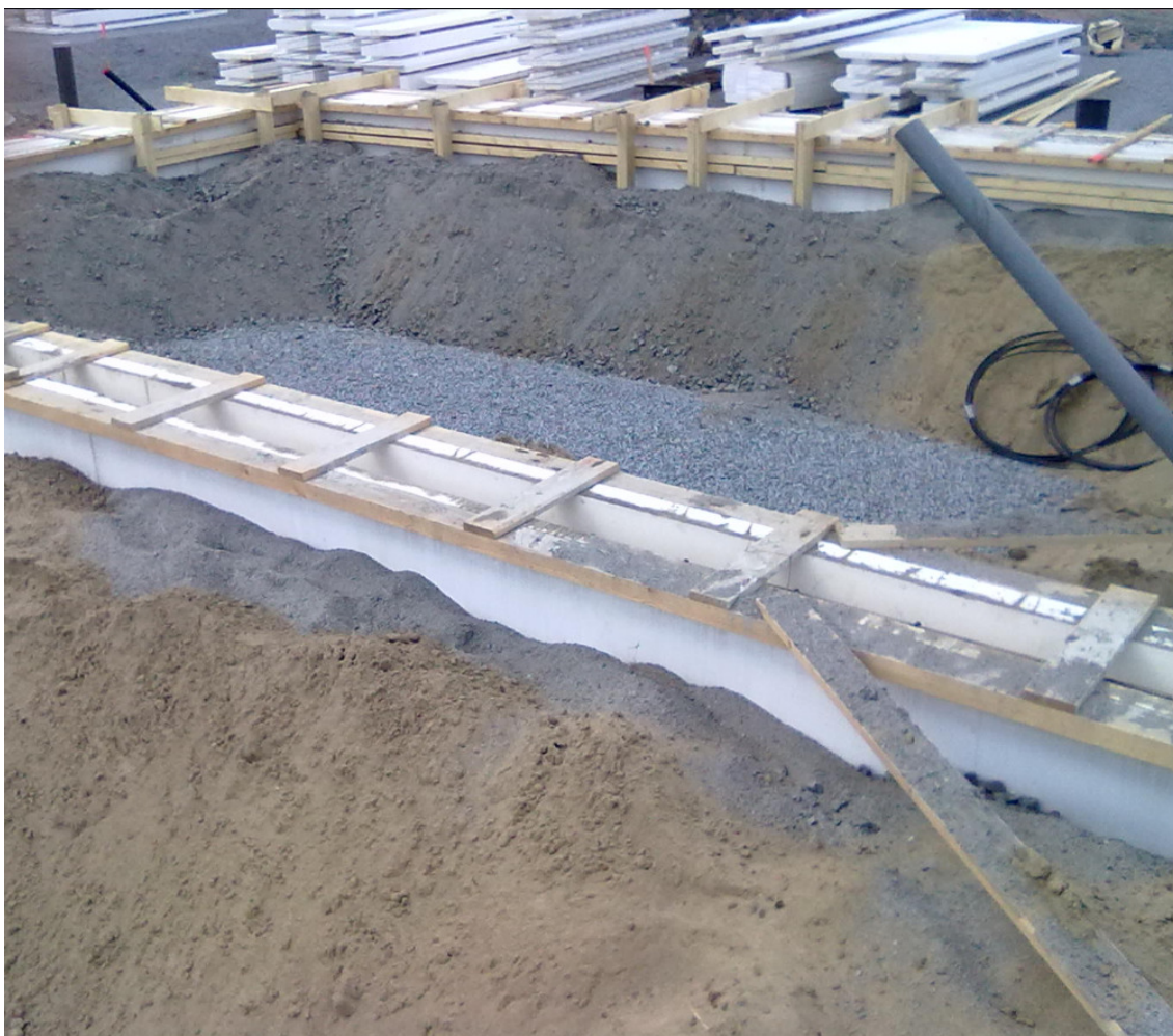
KUVA 6. Soklex-muotin tuenta perusmuurin sisäpuolella
