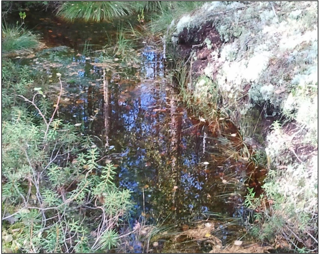
Kuva 2. Toimimaton lietekuoppa hankkeelta 3106. Kuva on tekijän ottama.
