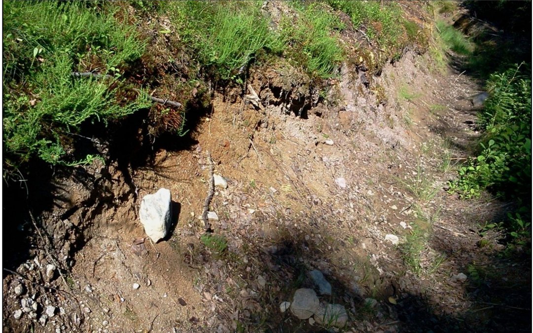
Kuva 4. Reunaerosio kivennäismaahan kaivetussa ojassa. Kuva on tekijän otama.
