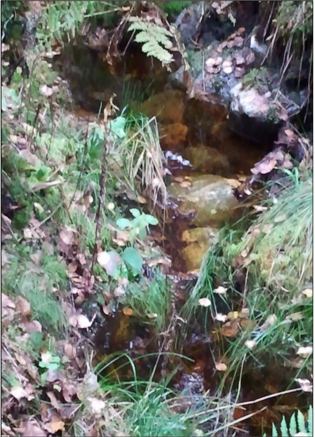
Kuva 4. Ojan Br erodoitunut alaosa. Kuva on tekijän ottama.
