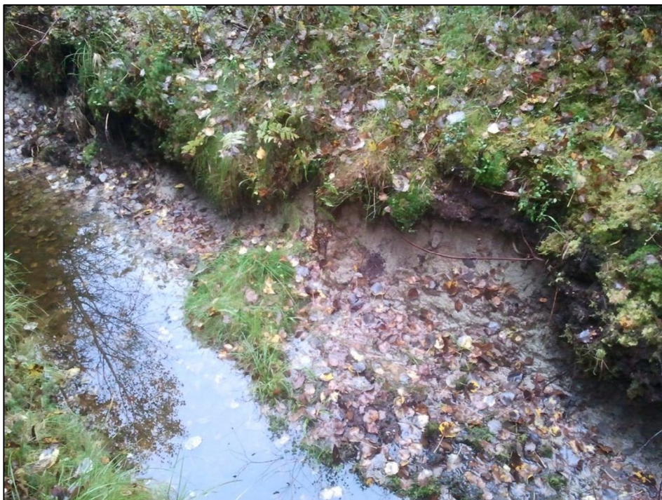
Kuva 4. Eroosio ojan rinteeseen puoleisella osalla. Kuva on tekijän ottama.
