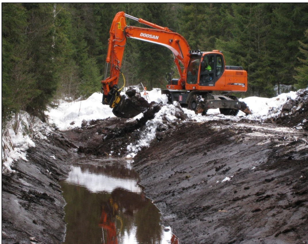
Kuva 2. Laskeutusaltan kaivu Renkajärvellä. Kuva on Matti Peltolan ottama. (Renkajärven suojeluyhdistys ry, 2011.)
