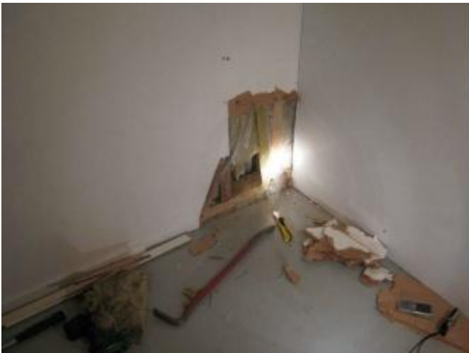
Kuva 3. Tutkimuskohteen kosteusmittausten mittapisteiden tulosten perusteella rakennetta avattiin. Kuva Jarmo Ihalainen.
