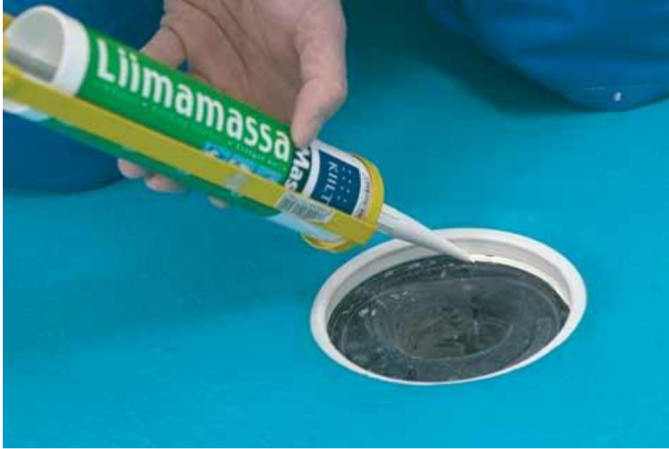
KUVA 14. Lattiakaivon ja kiristysrenkaan alareunan tiiveyden varmistaminen (Rakentaja 2012)
