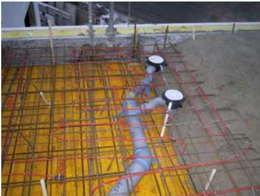
KUVA 9. Paikalla valettu välipohja (Betoni 2003)
