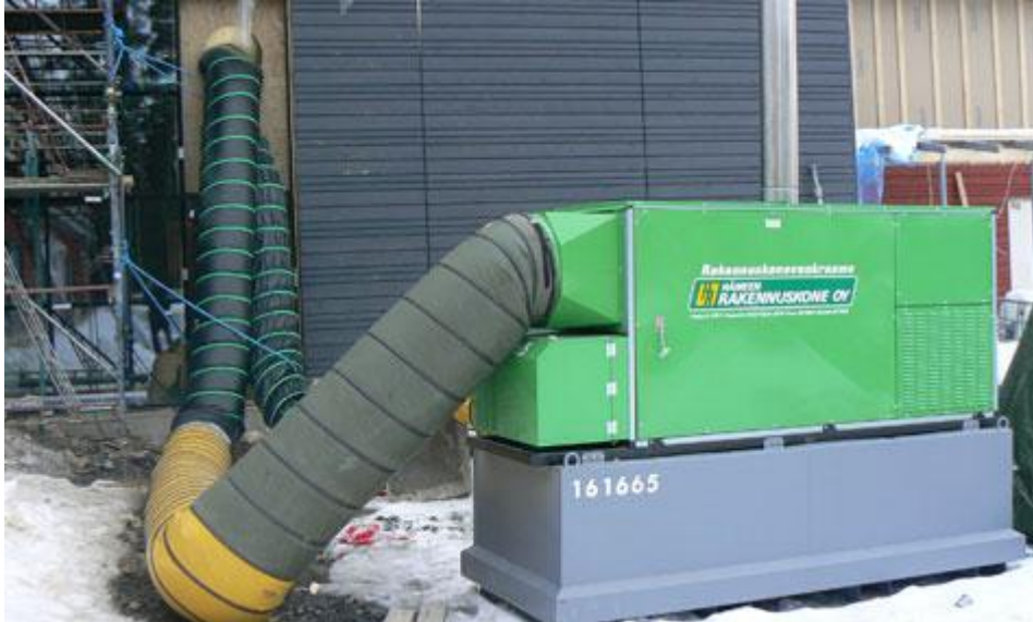
KUVA 12. Tehokas rakennusaikaiseen lämmitykseen soveltuva siirrettävä öljylämmitin (Hämeen Rakennuskone Oy 2012)
