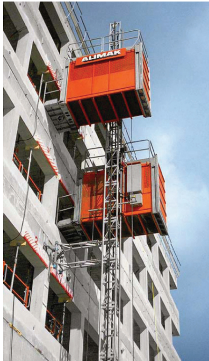
Kuva 10: Henkilötavarahissi (Talhu Oy 2)
