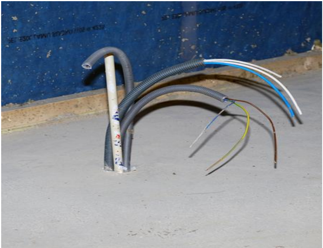
KUVA 5. Putkijohtoasennus lattiavalussa. (Pipelife)
