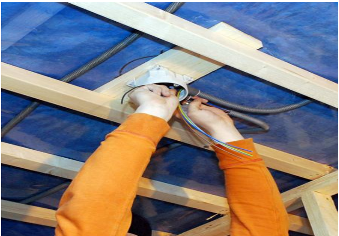
KUVA 6. Putkijohdon asennus kattorasialla. (Pipelife)
