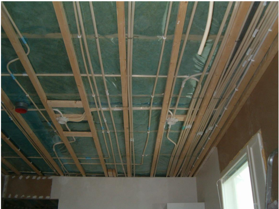
KUVA 2. Putkellinen asennustapa. (SähköKoskela)
