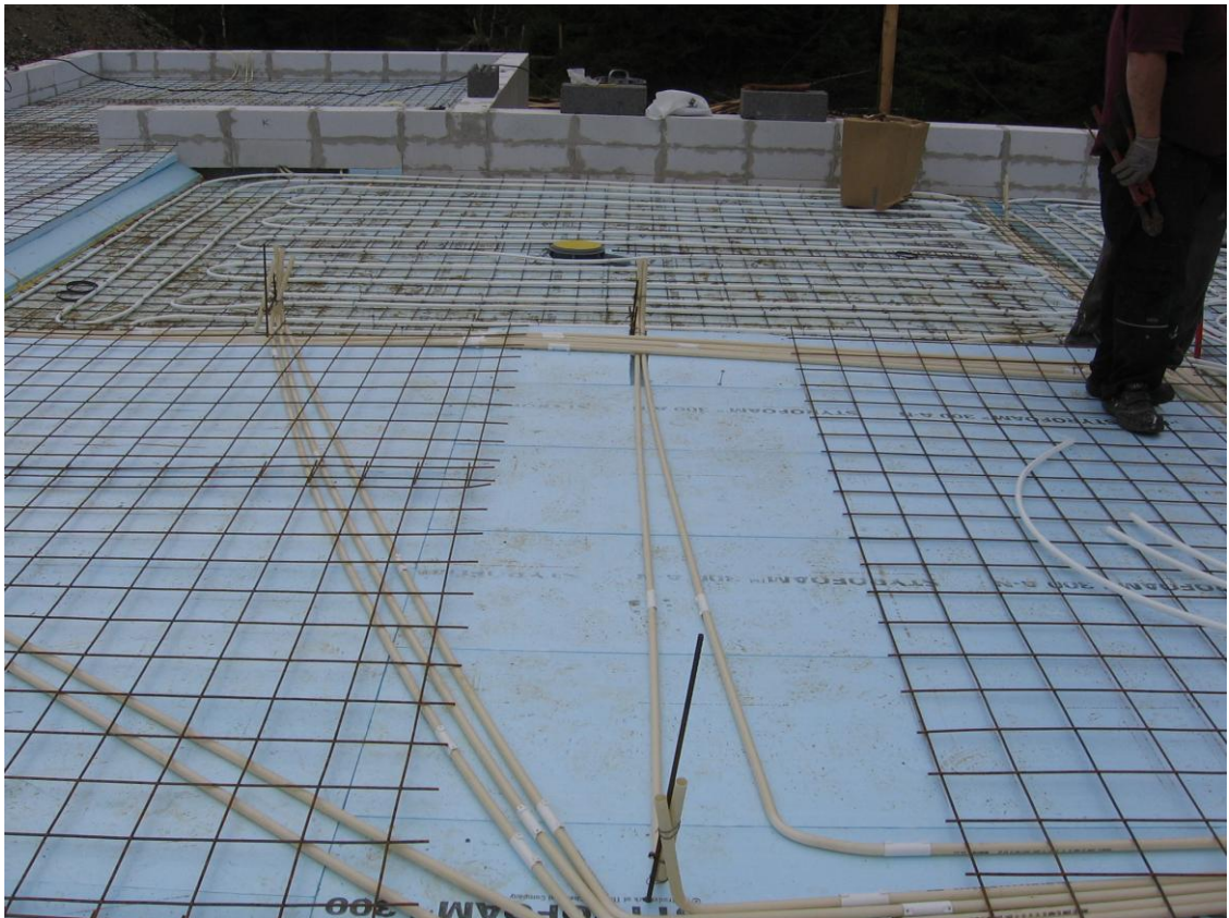
KUVA 4. Lattiavaluun asennetut suojaputket. (Sähkö Apila)
