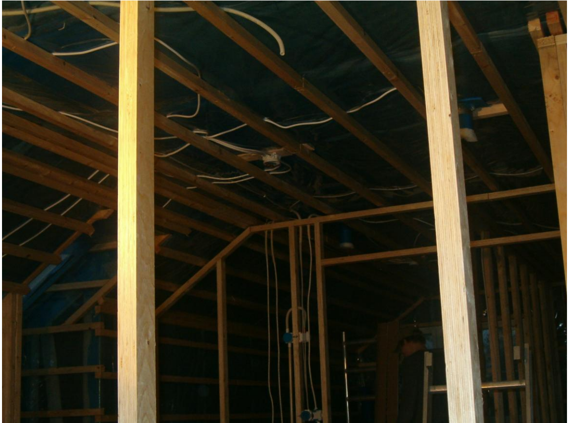
KUVA 3. Putketon uppoasennus. (SähköKoskela)
