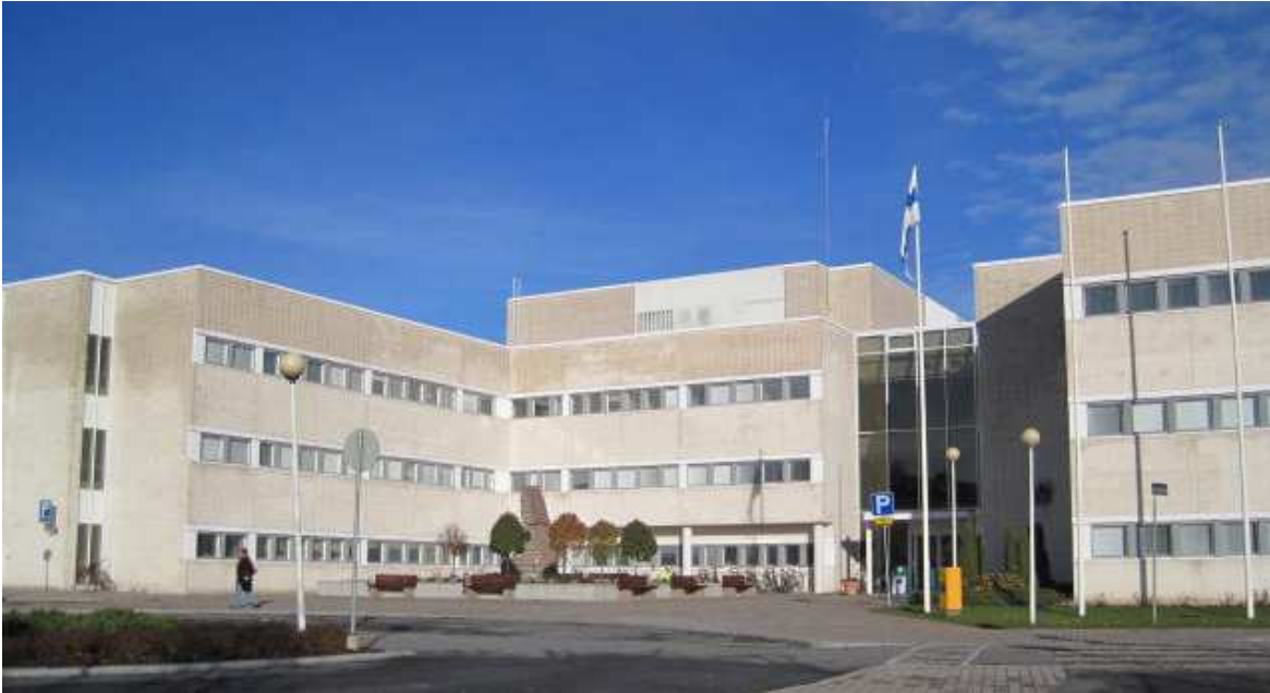
Kuva 5. Liedon kunnantalo. Liedon kunnantalossa sijaitsee ympäristönsuojelutoimen lisäksi muun muassa kaavoitustoimi, rakennusvalvonta ja osa ympäristöterveydenhuollon alueellista yksikköä.
