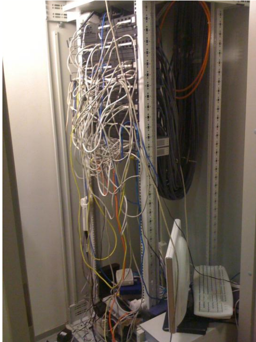
Kuva 63. Helsingin toimipisteen kytkentäkaappi
