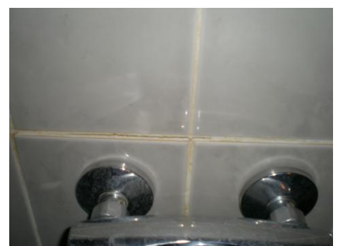
Kuva 14 Sekoittajan kohdalla laatta oli irti alustastaan ja sauma lohjennut
