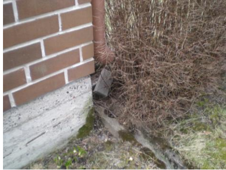
Kuva 16 Syöksytorven ja loiskekupin etäisyys on liian suuri
