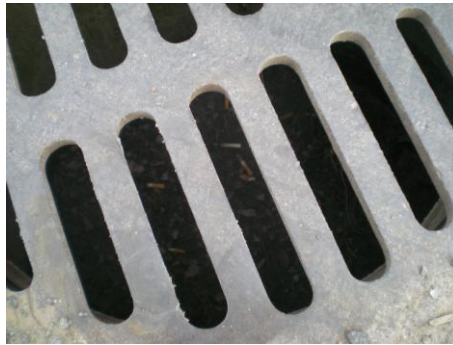
Kuva 18 Piha-alueella oleva sadevesikaivo
