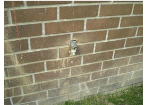
Kuva 10 Kasteluveden likaama seinä
