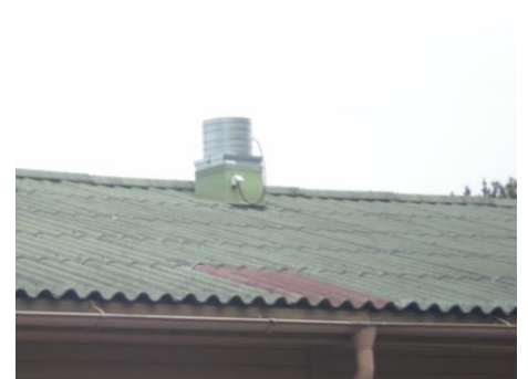
Kuva 22 Uusittu huippuimuri
