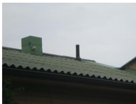
Kuva 24 Uusittu huippumuri
