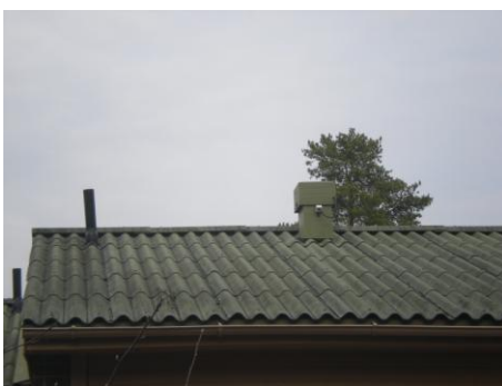
Kuva 23 Alkuperäinen huippumuri
