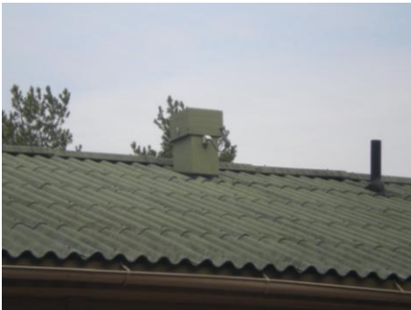
Kuva 20 Todennäköisesti alkuperäinen huippuimuri
