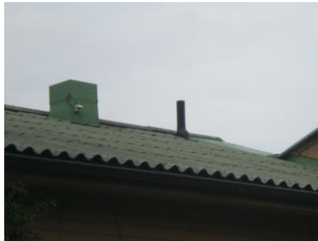
Kuva 21 Uusittu huippuimuri
