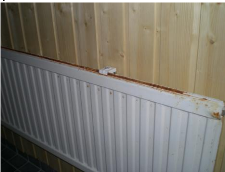
Kuva 18 D1 asunnon saunan patterissa pintaruostetta
