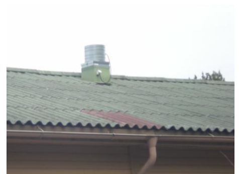
Kuva 25 Uusittu huippumuri
