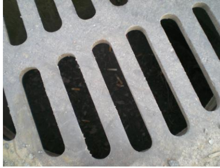
Kuva 22 Piha-alueella oleva sadevesikaivo
