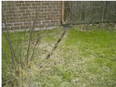
Kuva 20 Poistokouru on kasvanut umpeen, eikä johda vettä pois kunnolla
