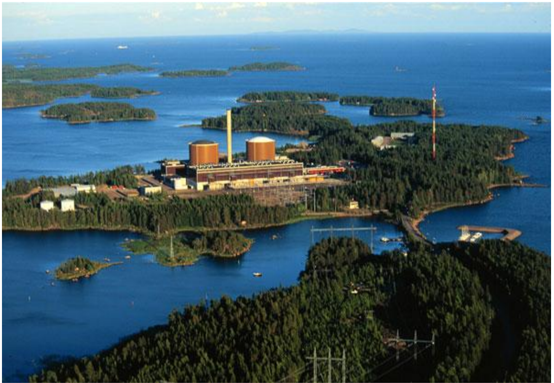
Kuva 4. Loviisan voimalaitos ilmasta kuvattuna (Fortum Oy.)
