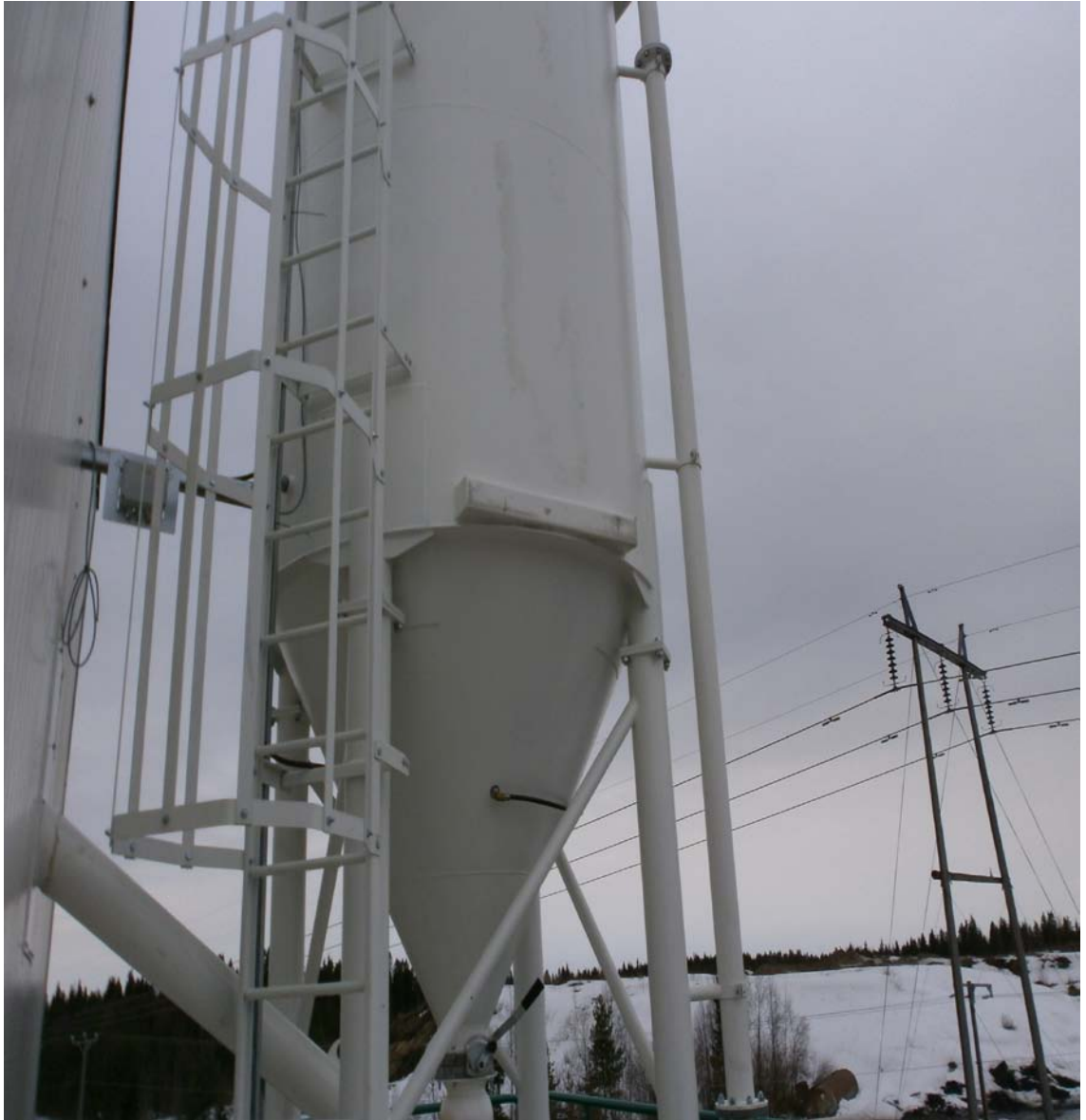
KUVA 5. Yläkerran siilo, sisältää poltettua kalkkia (Kuva: Mäkinen 04/2012)
