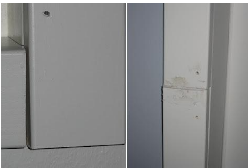
Bild 33. Bristfällig listning (Misasen loota 2012).
