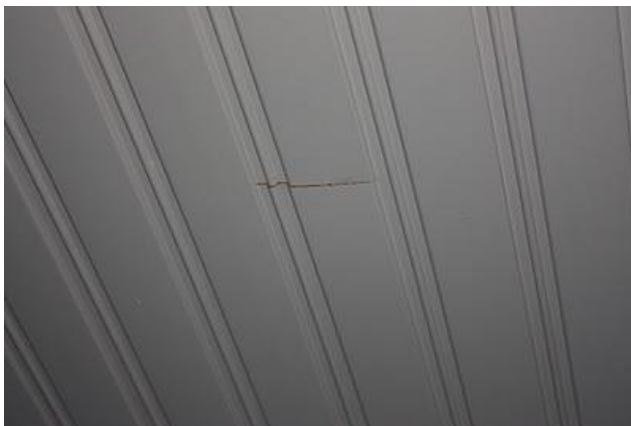
Bild 10. Panelskarv (Rauhalan rakentajat 2012).
