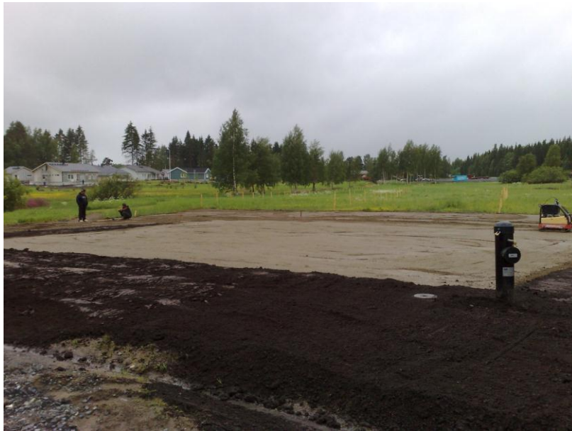
Kuva 10. Pohjatöiden tekoa Valkeakoskella.
