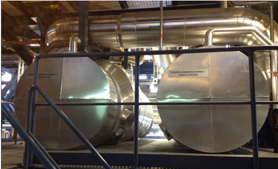
KUVA 18. Kaukolämmönsiirtimet
