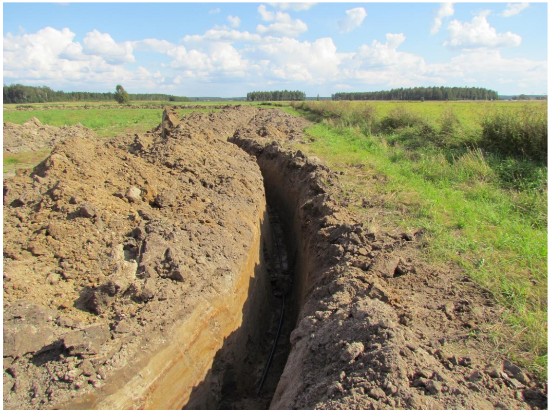
Kuva 4. Kaapelioja kaivamalla 40cm kauhalla vapaaaseen maahan.
