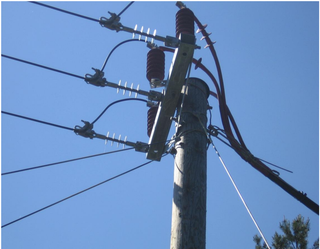
Kuva 1. PAS-johdosta lähtevä multikaapeli pylväsasennuksena ilmassa.
