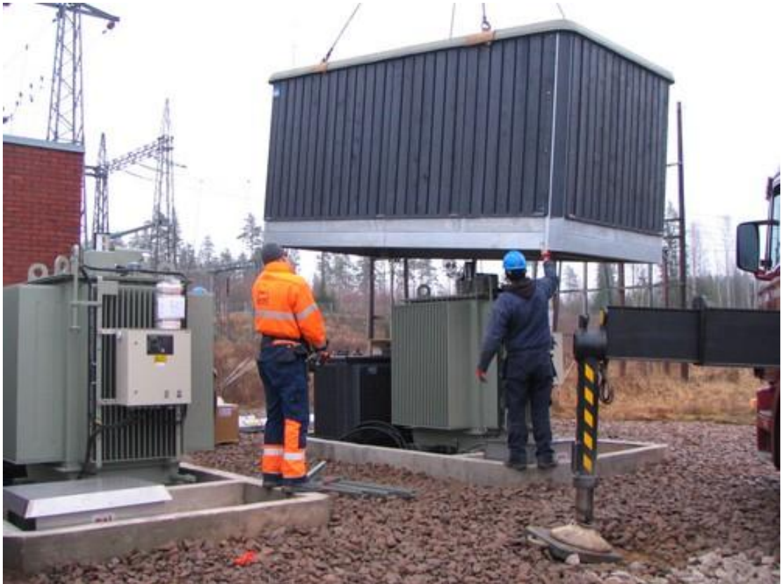
Kuva 3. Kompensontilaitteen asennusta sähköasemalla
