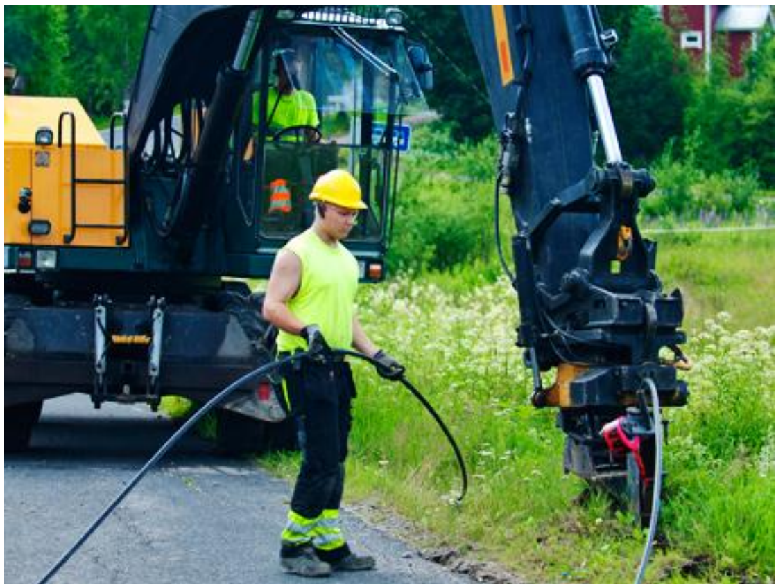
Kuva 5. Kaapelin aurausta maantienlaitaan
