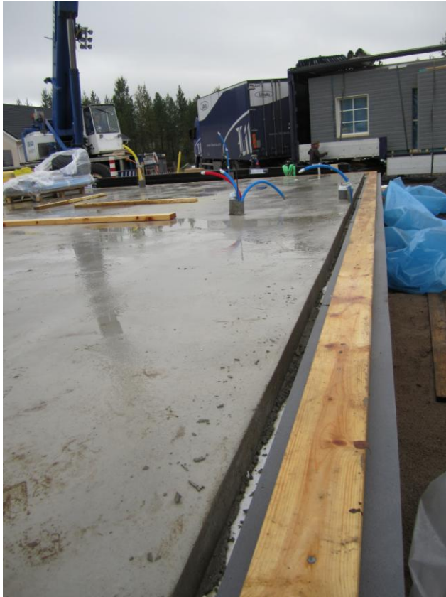
KUVA 1. Ennalta valettuun betonilaattaan jätetään ns. jälkivalukaista höyrinsulkumuovin tiivistämistä varten
