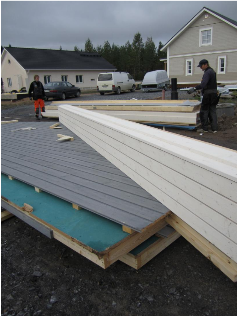
KUVA 8. Päätyräystäselementti asennetaan päätykolmioelementtiin maassa
