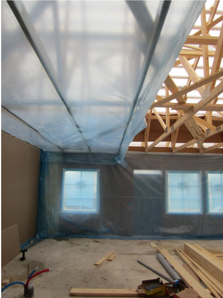
KUVA 4. Seinäelementin suojamuovi nostettuna yläpohjan höyrynsulukuksi
