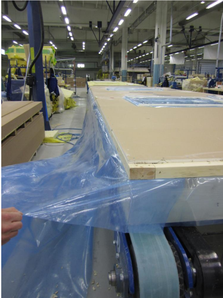
KUVA 2. Yläpohjan höyrynsulkumuovin limitys seinän höyrynsulkumuovin kanssa
