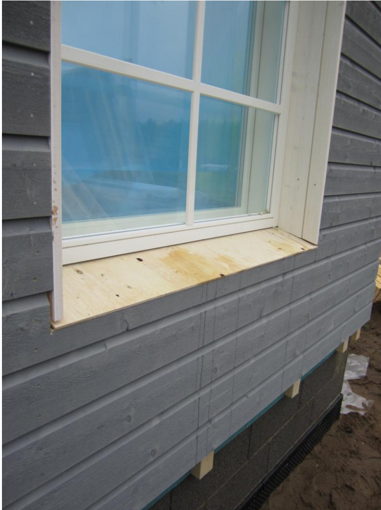
KUVA 7. Ikkunapellin alle asennettava vanerilevy kosteussuojana
