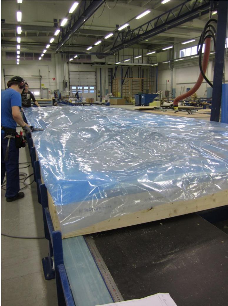
KUVA 3. Seinäelementin sisäpinnan kosteussuojan asentaminen
