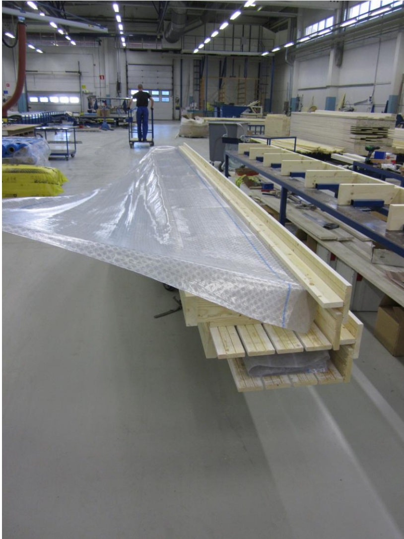
KUVA 9. Päätyräyselementtiin asennetaan tehtaalla aluskateluiska
