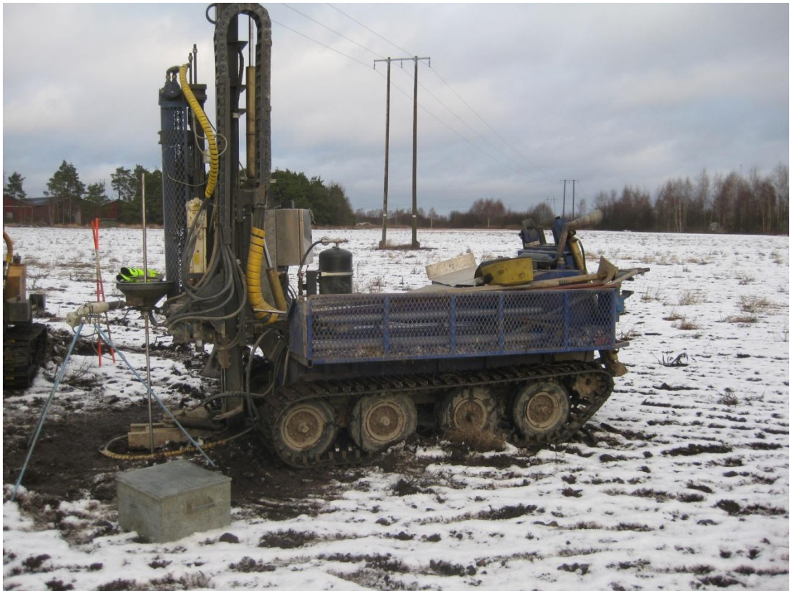
KUVA 25. Kairavaunu Nilcon-kairalaitteella, Laitila.
