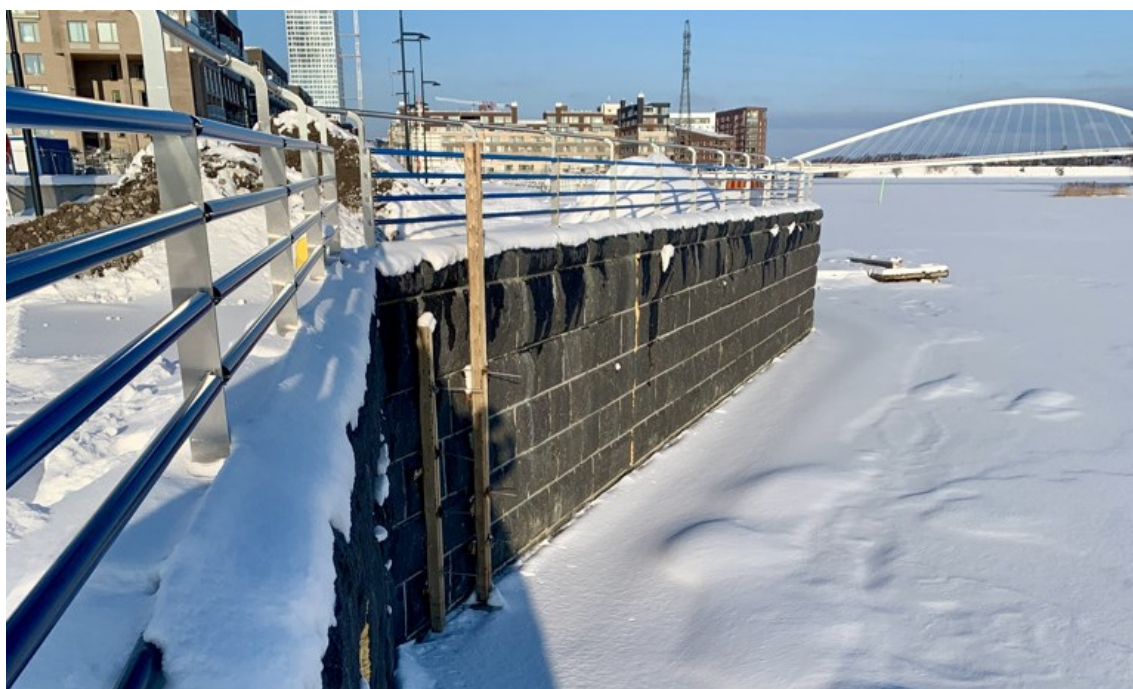
Kuva 17. Valmis kiviverhoiltu teräsbetoninen rantarakenne.
