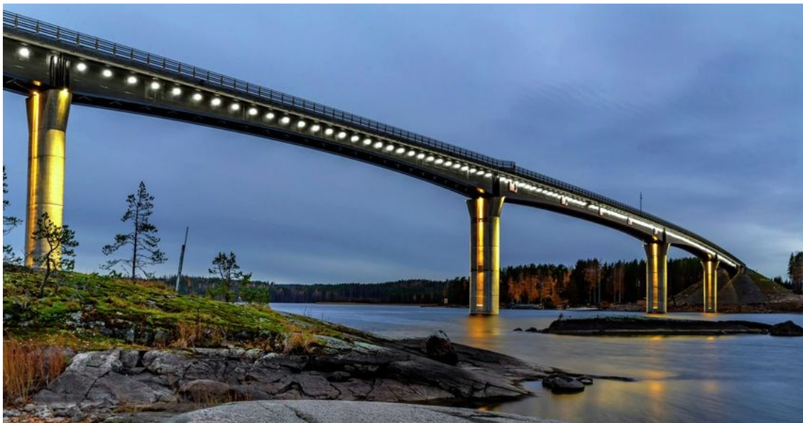
Kuva 11. Vekarasalmen silta, jonka urakoitsijana toimi GRK Infra Oy.
