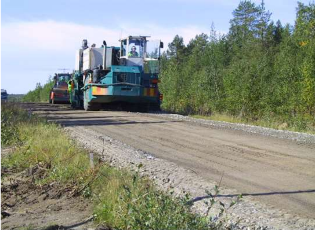
Kuva 9. Andament Oy:n Stabilointijyrsin tekemässä masuunihiekkastabilointia (Salmijärvi 2004, 22).
