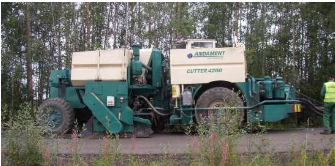
Kuva 4. Andament Oy:n stabilointijyrsin tekemässä vaahtobitumistabilointia
