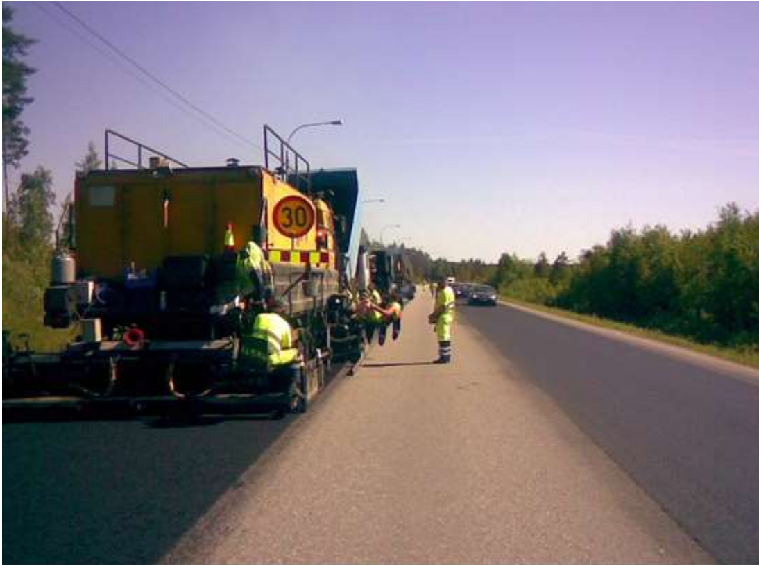
Kuva 2. Skanska Industrial Solutions Oy:n Roadmix 4 remix-kone tekemässä REM-pintausta.
