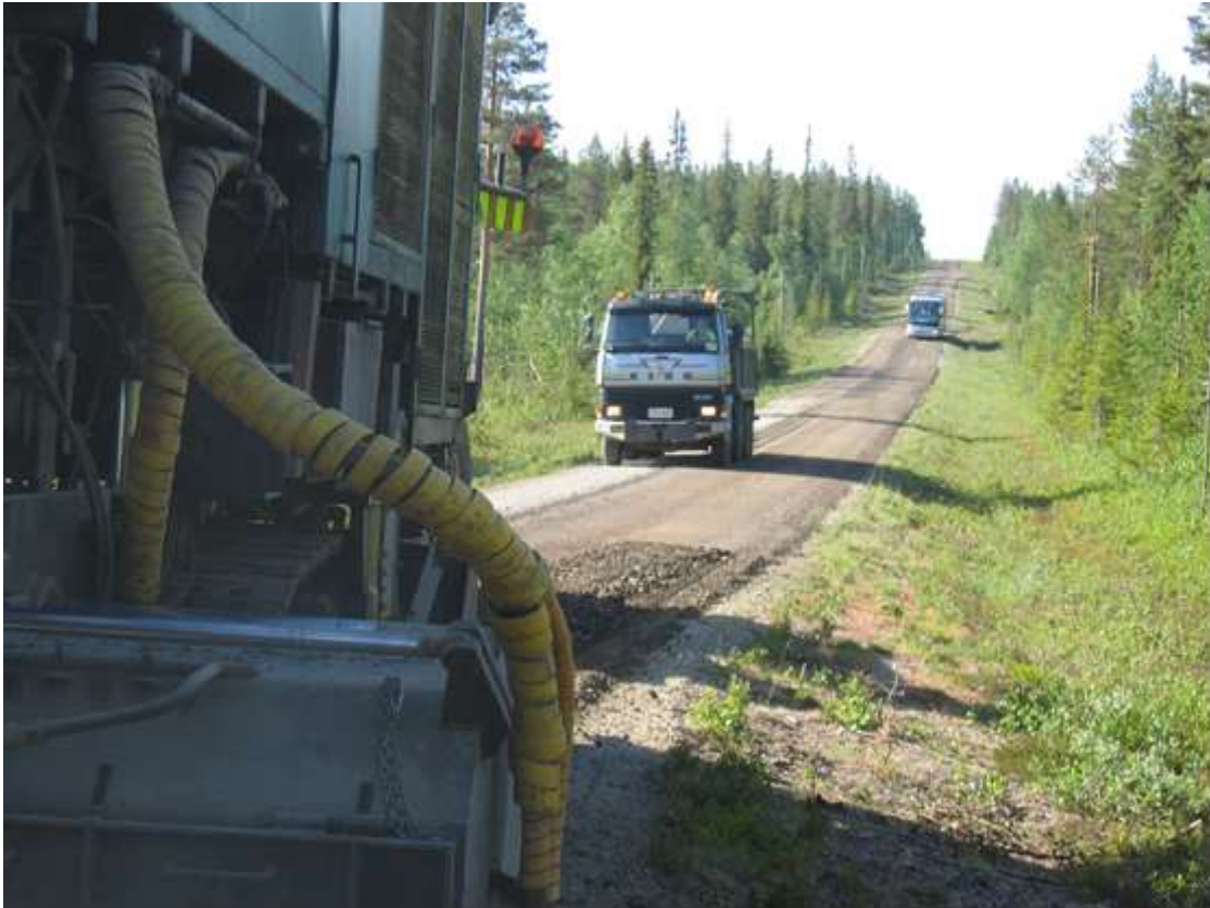
Kuva 10. Tie on ajettavassa kunnossa sekoitusjyrsinnän ja esitiivistyksen jälkeen.
