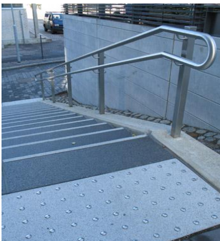
KUVA 38. Kahden korkeuden käsijohde (Näkövammaisten Keskusliitto ry)
