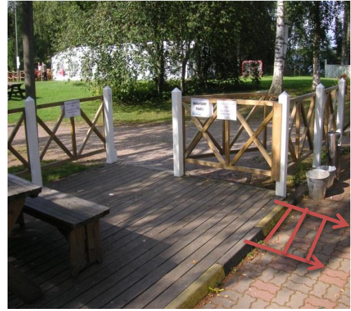
KUVA 18. Maaterassin sisäinen tasoero
