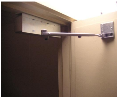
KUVA 22. Ovipumppu
