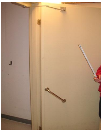
KUVA 25. Vedin ja ovipumppu
