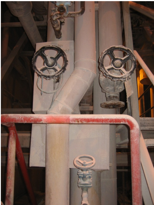
KUVA 9. HMP- ja HVP-linjojen tulot esilämmittimien höyrylinjaan
