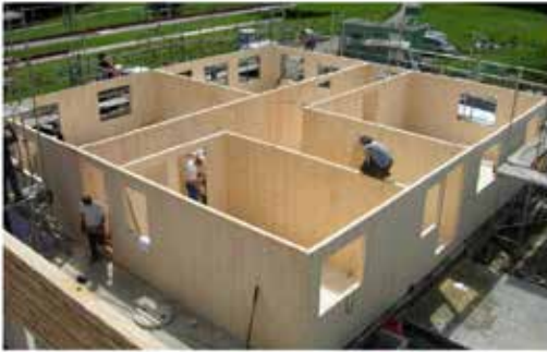
Kuva 266 CLT- puukerrostalon runko /11/
