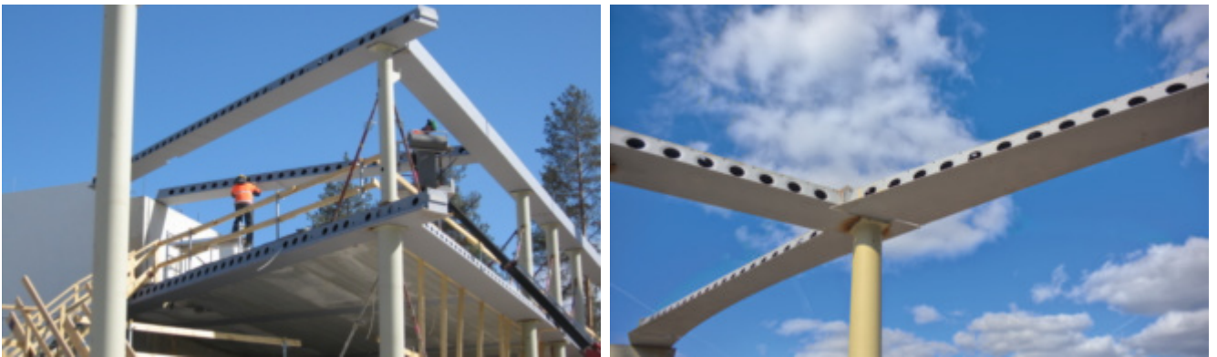
Kuva 282 Peikko- liittorunko /22/
