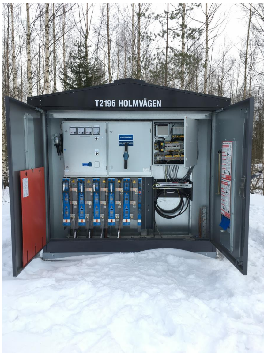
Figur 11. Parktransformatorstationen där IPC4020 utrustningen har sin mätning.
