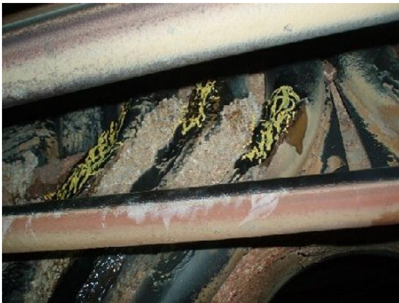
Kuva 10. Miesluukun ”O4” heittoputkien päällehitsattavat kohdat. /9/
