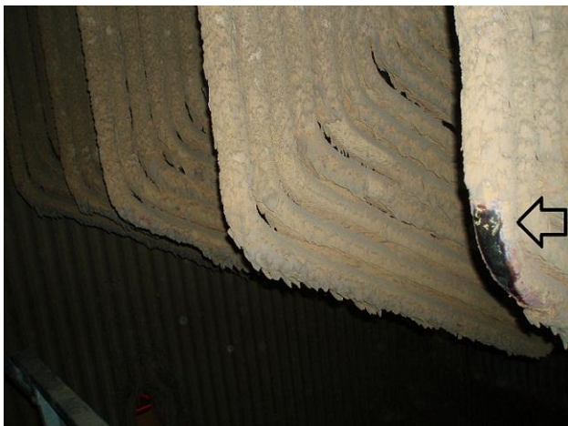
Kuva 12. Tulistin 2:n alin mittauskohta. /LIITE 1/
