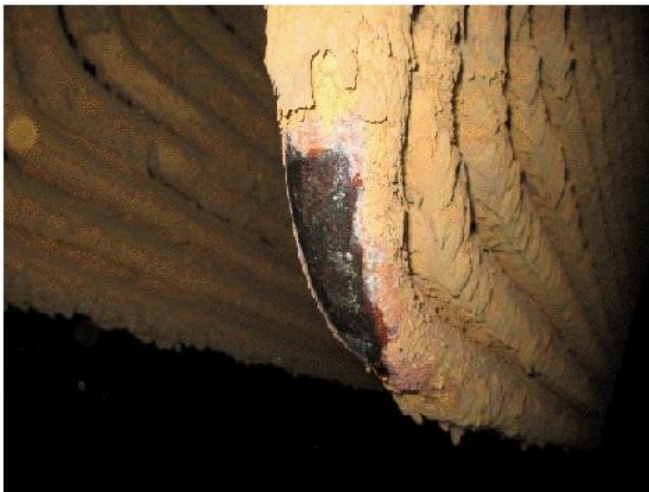
Kuva 8. Ultraäänimittausta varten poistettu epäpuhtaudet tulistin2 pinnalta.
