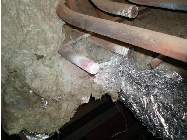
Kuva 14. Tulppaus toteutettu tulistin 3:ssa. Valkoinen aine on NDT -testin kehitettä. /9/
