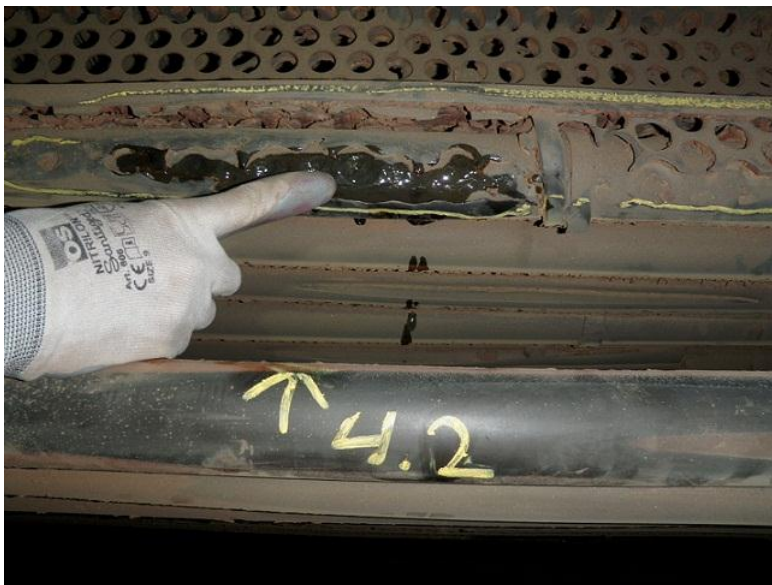
Kuva 15. Tulistin 3:n takaseinän reunakohta levytetty (vanha levy). /9/
