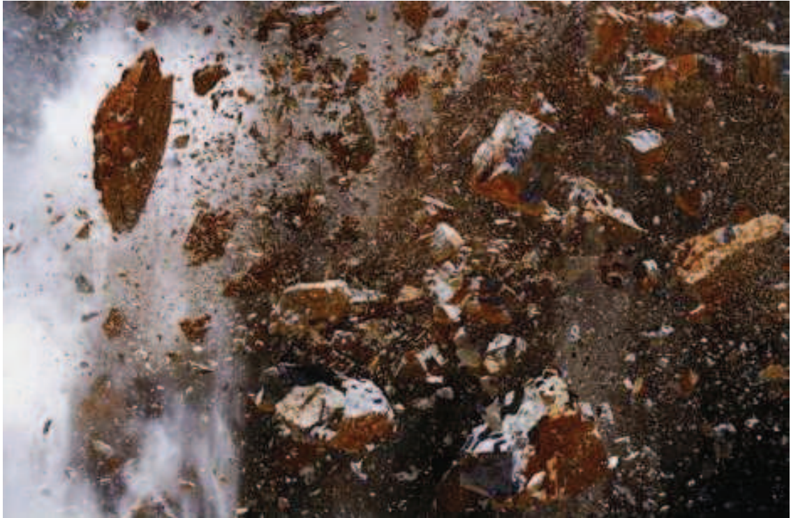
Kuva 6. Vaarattomammissa kohteissa voidaan panostusta lisätä, jotta louheesta tulee kuohkeampaa ja näin helpommin kuormattavaa.[11.]
