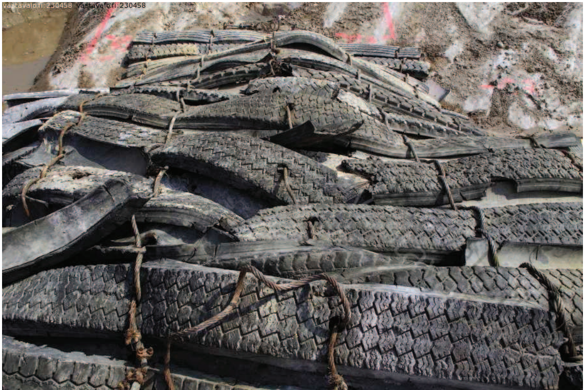
Kuva 7. Täkkäyksenä käytetään vanhoista autonrenkaista tehtyä peitemattoa.[12.]
