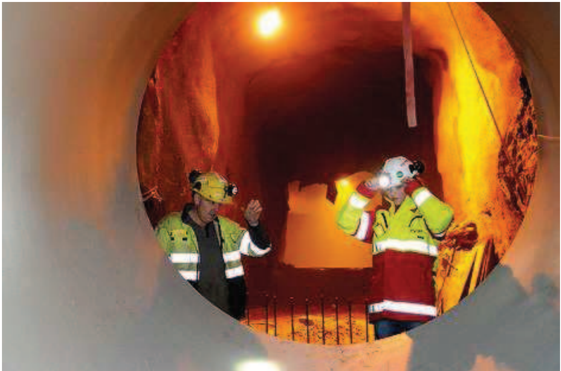
Kuva 2. Lemminkäinen tekee Norjassa tunnelitöitä.[4.]
