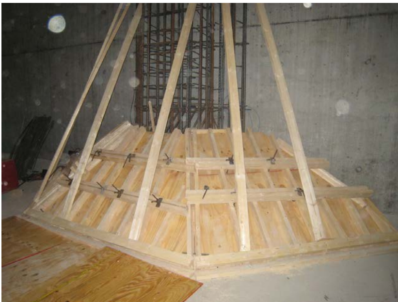
KUVA 10. Pilasterin jalkaosan muotti
