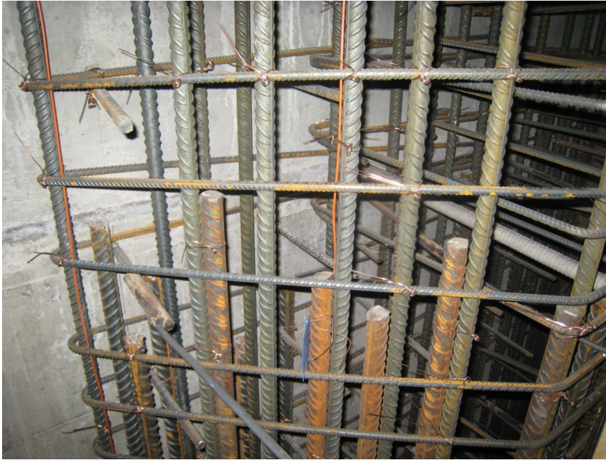
KUVA 8. Oransseja vastuslankoja yläosan raudoituksessa
