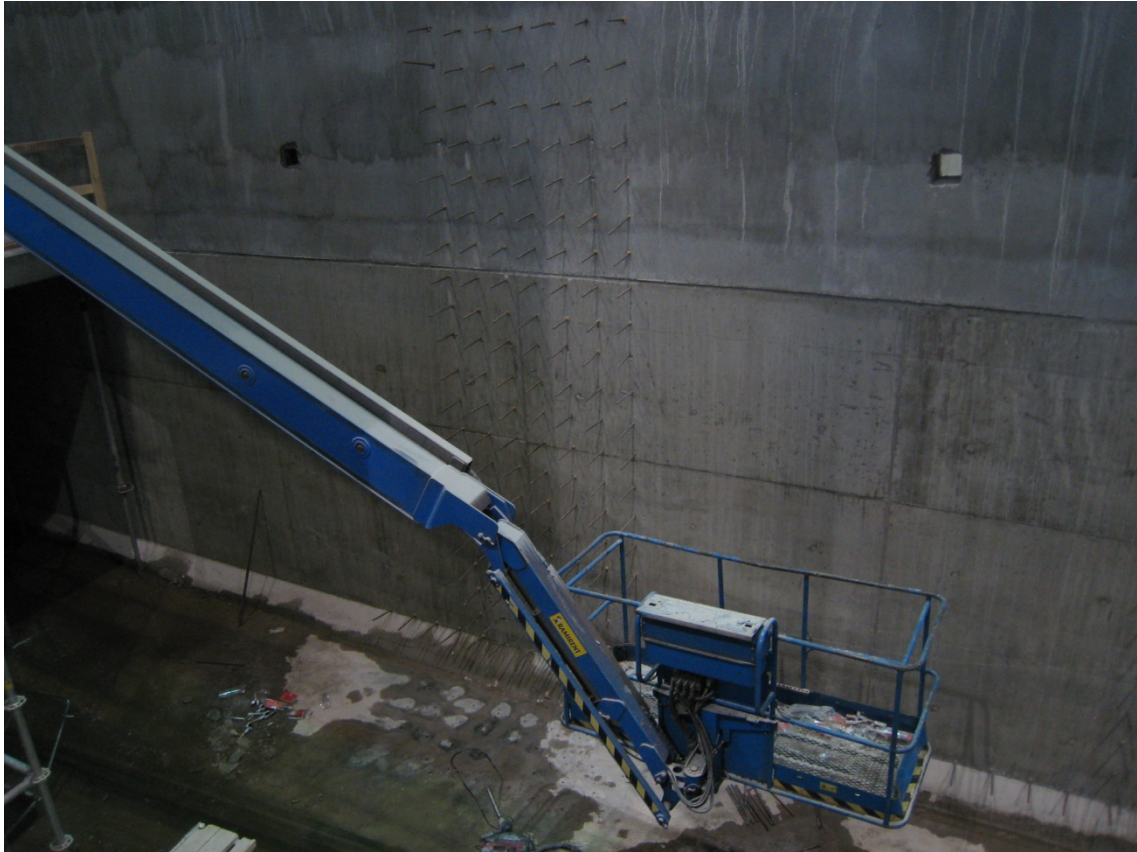
KUVA 6. Toisen pilasterin seinätartunnat asennettu
