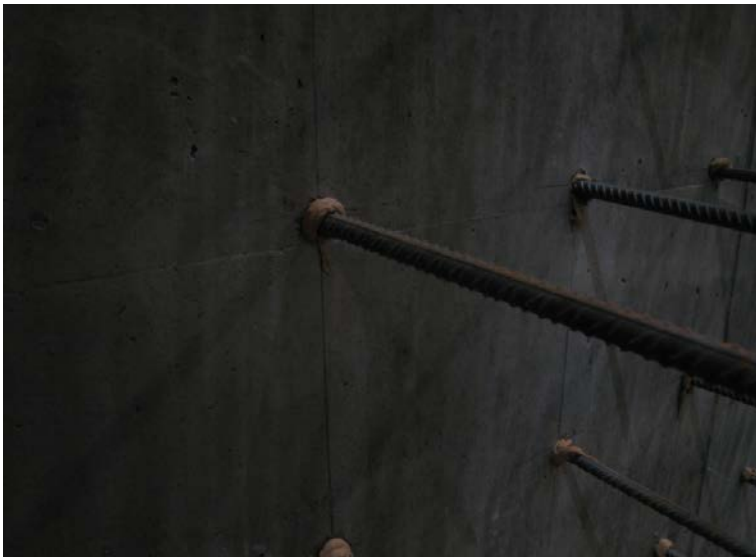
KUVA 5. Asennettu seinätartunta
