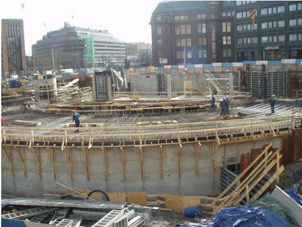
Kuva 13. Paikallavaletun rakennuksen työmaa (Ramirent, 2012).
