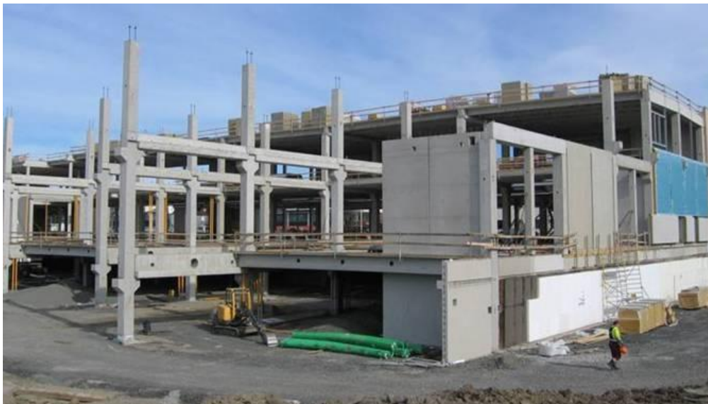
Kuva 17. Pilari-palkki -runkoisen rakennuksen periaatekuva (Elementtisuunnittelu, 2012).
