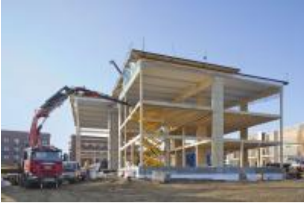
Kuva 20. Pilari-palkkirunkoinen puukerrostalo (Puuinfo, 2012).
