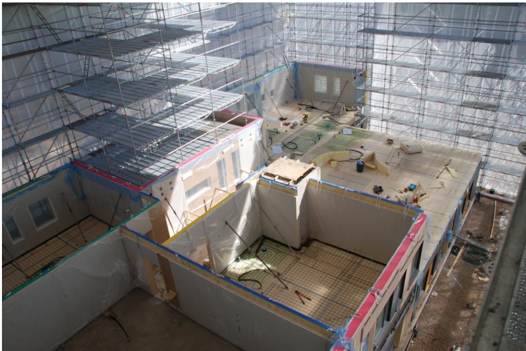
Kuva 3. Sääsuoja sisäpuolelta (Fiste 2012).
