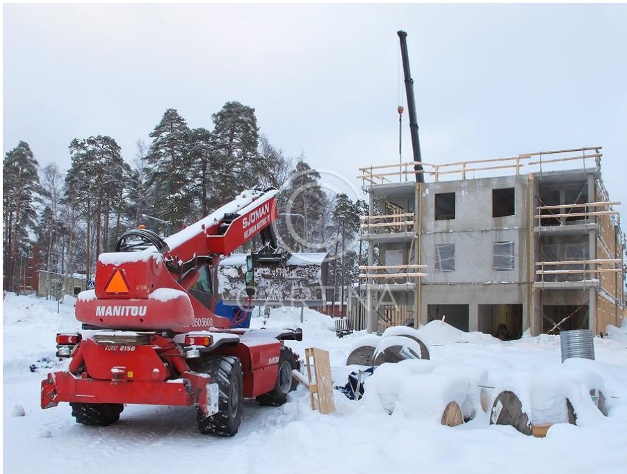
Kuva 1. Perinteistä asuinkerrostalorakentamista (Cartina, 2012).
