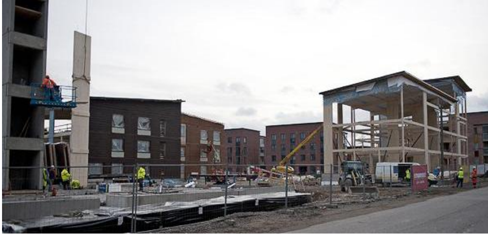
Kuva 24 Helsingin Viikkiin rakentuva puukerrostalokortteli on Finnwoodin ja Peab Oy:n yhteistyöprojekti (Peab, 2012).
