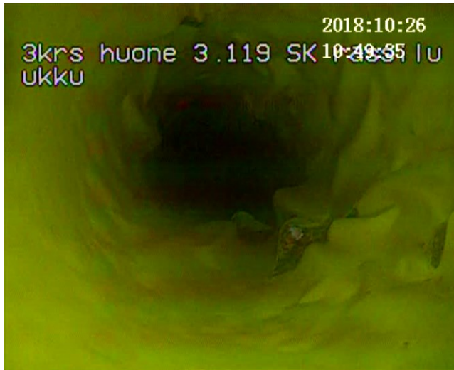
Kuva 8. Esimerkki dimension supistumisesta vaurioiden vuoksi [6]
