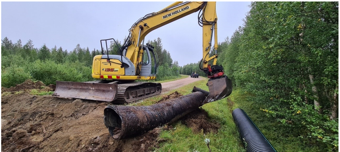
Kuva 4. Lyhytperäinen tela-alustainen kaivinkone 2020
