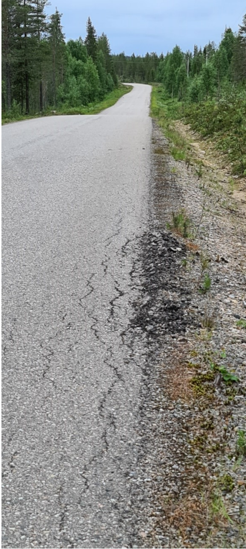
Kuva 13. Reunapainumaa päällystetyllä tiellä
