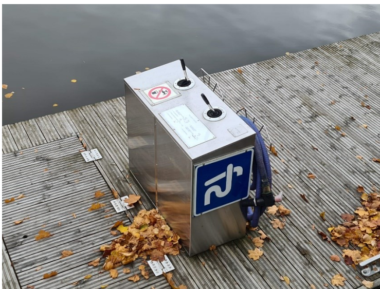
Kuva 73. Etelärannan Rti-Septi imutyhjennyslaituri
