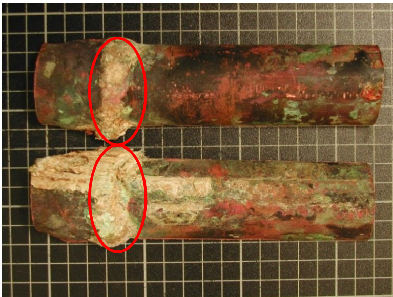
Kuva 4. Sinkin katoa kupariputken ulkopinnalla (Vahanen Oy)
