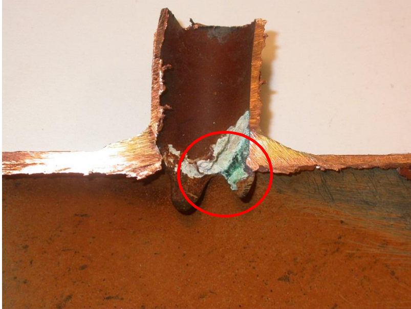
Kuva 5. Sinkinkatoa kupariputkien liitoskohdassa (Vahnen Oy)
