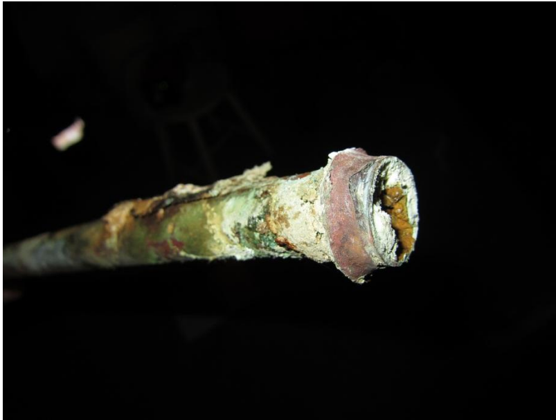
Kuva 7. Sinkinkadon korroosiotuote on kertynyt kupariputken sisälle (Vahanen Oy)
