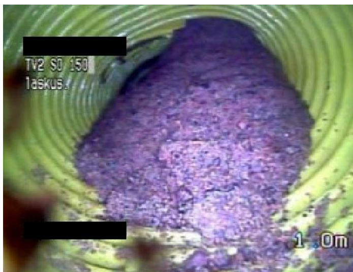
Kuva 13. Salaojaputkessa on hiekkatukos, mutta se ei estä kokonaan putken toimintaa kaivojen välisellä putkiosuudella (Vahanen Oy)
