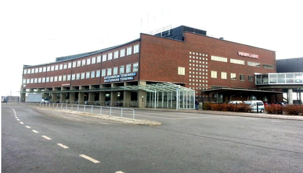
Kuva 1: Katajanokan laivaterminaali, Viking Line.
