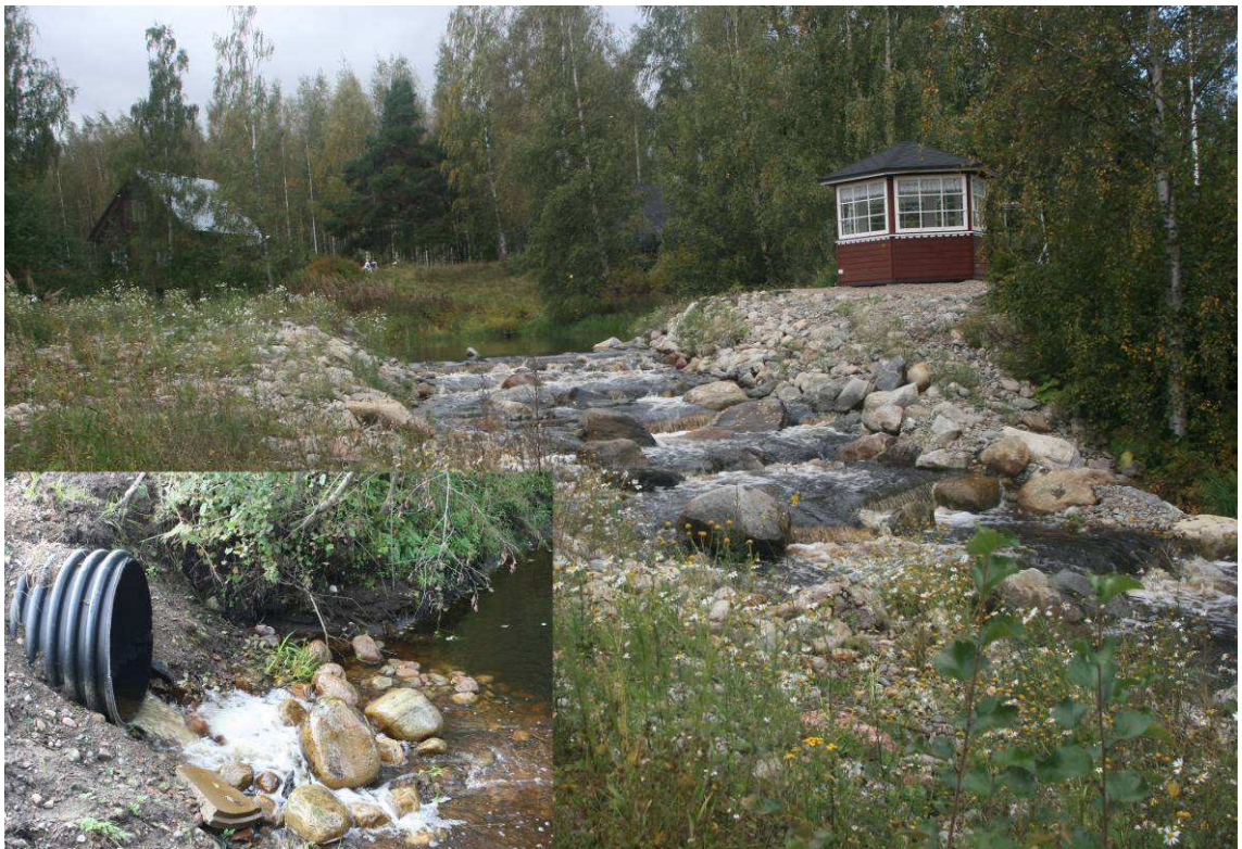
KUVA 7. Esimerkkejä pohjapadoista. Vasemmalla ojarummun päähän tehty pato, alla porrastettu ja padottu lasku virtauksen hidastamiseksi. (Kuva: Metsäkeskus)
